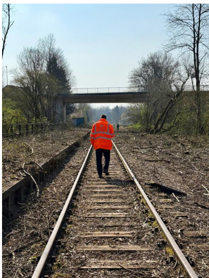
Projektleiter Sebastian Ottrembka läuft die Strecke ab (März 2026) [Quelle: DB InfraGO AG]
