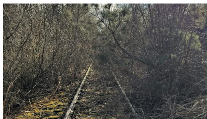
Blick auf den stillgelegten Abschnitt bei Homburg-Beeden (Februar 2025) [Quelle: DB InfraGO AG]
