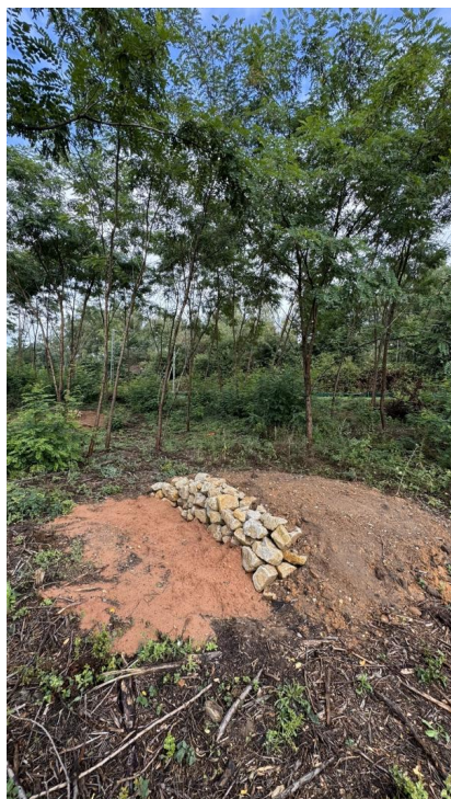
Fertigstellung der Interimsfläche für Eidechsen auf der Fläche im Gleisdreieck an der Saarbrücker Straße in Homburg (Juli 2025) [Quelle: DB InfraGO AG]
