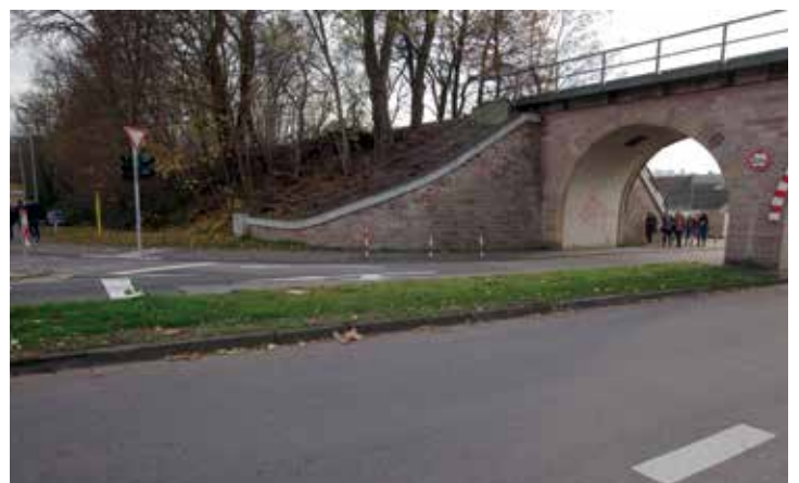
Der Bahndamm zwischen der Neuen Bahnhofstraße und der Dudweilerstraße wurde mit dem Erdreich aufgeschüttet, das beim Bau des Rotenkopf-Tunnels abgegraben wurde.
