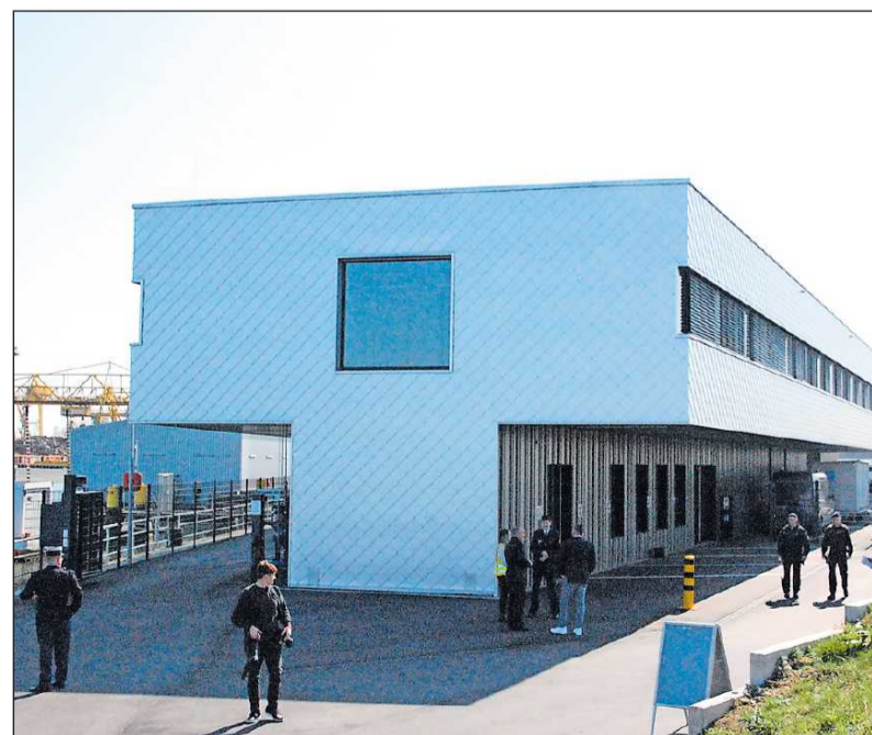
Am Kehler Rheinhafen steht das neue Gebäude für die deutsch-französische Einheit der Wasserschutzpolizei. FOTO: NÜCK
