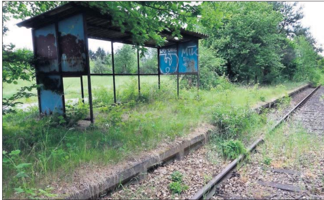
Dornröschenschlaf: Der verwaiste Bahnhof Beeden an der alten Trasse Homburg - Zweibrücken. FOTO: MOSCHEL
