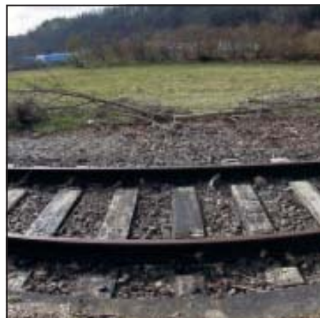
Warten auf Zugverkehr: Die Gleise zwischen Zweibrücken und Homburg, hier ein Teilstück in Höhe von Einöd. FOTO: MOSCHEL
